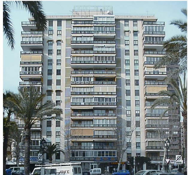
Edifici Frontalmar JChV (2001)
